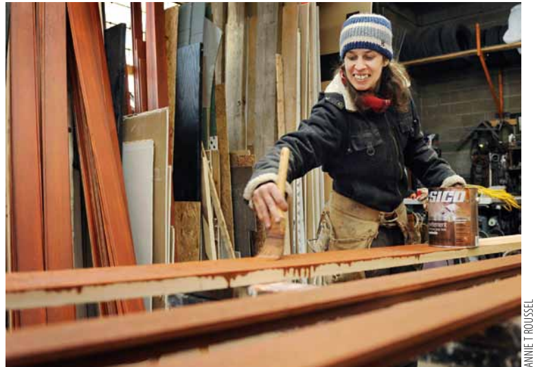
Parmi les mille et un métiers qu'elle exerce dans le cadre de son travail, Josée teint les planches de bois qui serviront de revêtement pour la bâtisse.
